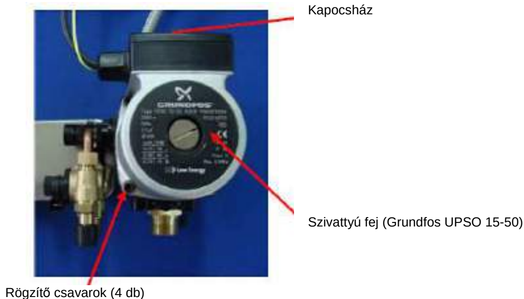
15.9 ábra: A CombiTEK készülék fűtési szivattyúja
