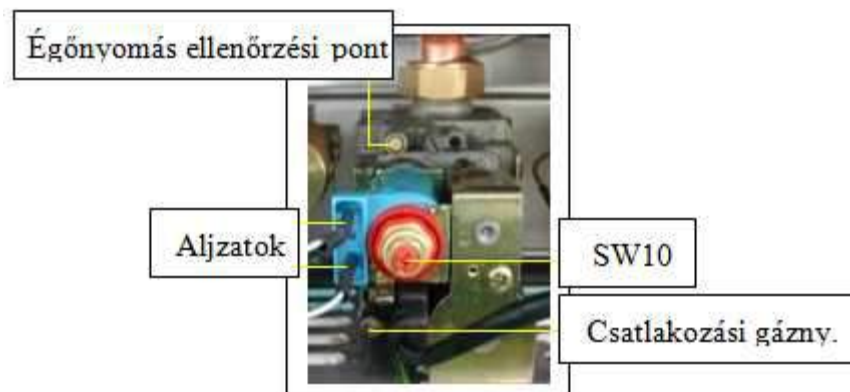
13.1 ábra: A CombiTEK készülék gázarmatúrája
