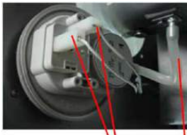
Elektromos vezetékek Nipolán cső
