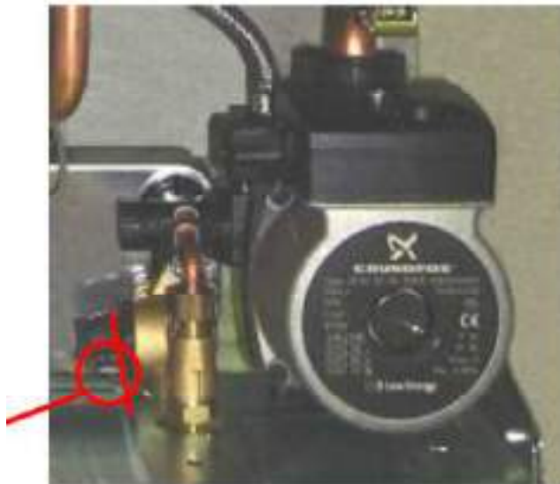
15.30 ábra: A CombiTEK készülék áramlásérzékelője
